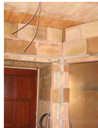
Příklady použití překladů Porotherm KP 11,5 a 14,5
