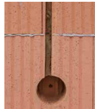
Připravená drážka pro elektroinstalaci
