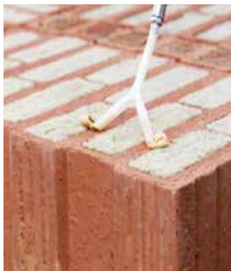
Pomocí speciálního nástavce na pistolí se nanese dva tenké pruhy lepidla
