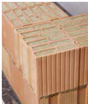
Vazba rohu vnější stěny Porotherm 38 T Profi
