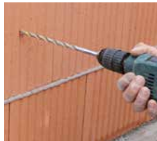
Otvory vždy vrtejte ostrým vidiovým vrtákem bez přiklepu!
