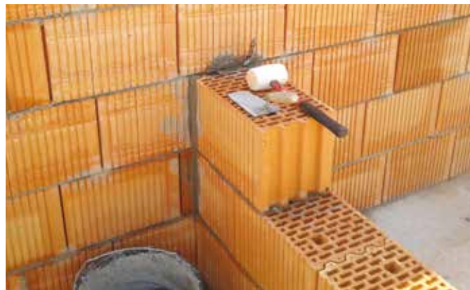
Příklad napojení vnitřních stěn tl. 240 mm
