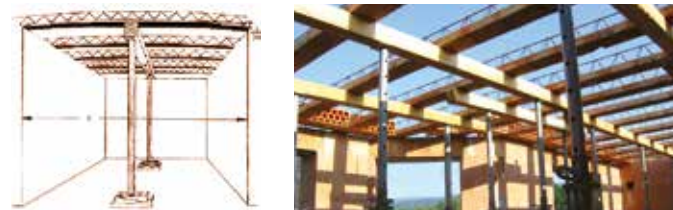
Schéma a foto podepření Porotherm stropu
