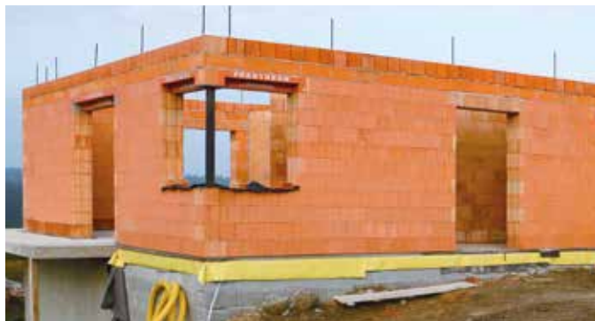
Výbornou tepelnou ochranu zajišťují vnější stěny z cihel Porotherm T Profi, resp. Porotherm T Profi Dryfix plněné minerální vatou
