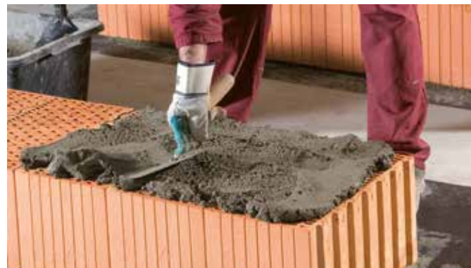
Malta ložné spáry naneste na podklad ve stejné šířce jako je tloušťka stěny
