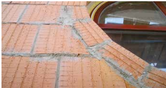
Podklad pod omítky musí být maximálně rovinný se zcela vyplněnými spárami mezi jednotlivými cihlami až do líce zdiva
