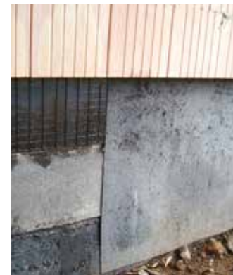
Pro stavby menšího rozsahu typu RD apod. je nejčastěji prováděna povlaková hydroizolace na bázi asfaltových modifikovaných pásů
