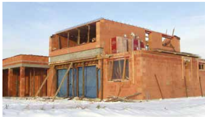
Stěny z broušených cihel Porotherm T Profi Dryfix lze vyzdívat na lepidlo pro zdění Porotherm Dryfix.extra až do teploty okolního prostředí -5 °C
