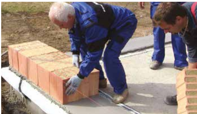
Stavební technik proškolí pracovníky stavby ze založení a zdění stěn z použitého typu broušených cihel Porotherm
