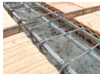
Ztužující příčné železobetonové žebro v šířce 250 mm (na délku jedné vložky)
