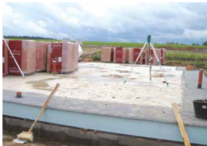
Před zahájením zdění je důležité vytýčení polohy nosného zdiva na základové desce včetně kontroly úhlopříček a vyznačení polohy otvorů
