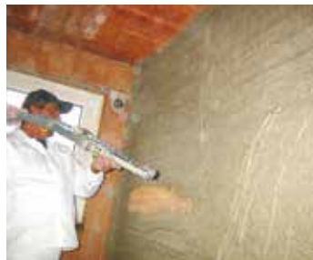
Nanášení vnitřní lehké omítky strojní technologií
