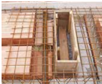
Příklady komínové výměny pomocí vložek MIAKO 8/62,5 (8/50) PTH
