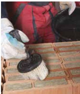
Žebra cihel ve zdivu doporučujeme před aplikací lepidla navlhčit
