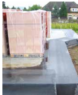
Pro stavby menšího rozsahu typu RD apod. je nejčastěji prováděna povlaková hydroizolace na bázi asfaltových modifikovaných pásů
