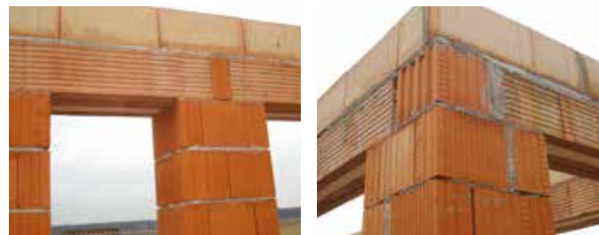
Příklady okenního nadpraží pro tloušťku stěny Porotherm 300 mm
