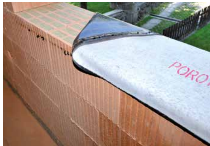
Zakrytí hydroizolačním pásem Porotherm ZIP-H vybaveným lepicí páskou
