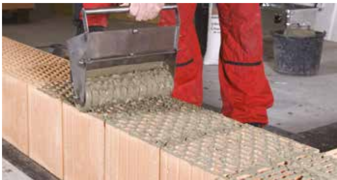
Zdění nosných stěn na maltu pro tenké spáry pomocí nanášecího válce
