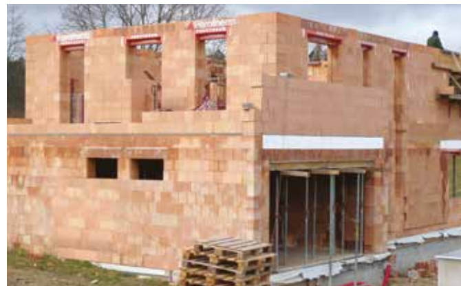
Příklad použití Porotherm KP XL 30 jako průvlak
