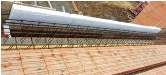
Překlady KP XL svými délkami plynule navazují na překlady KP 7, které jsou pro světlá rozpětí otvorů od 75 do 300 cm
