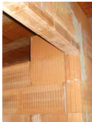
Příklady použití překladů Porotherm KP 11,5 a 14,5
