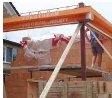
Osazení překladu KP Vario včetně izolantu
