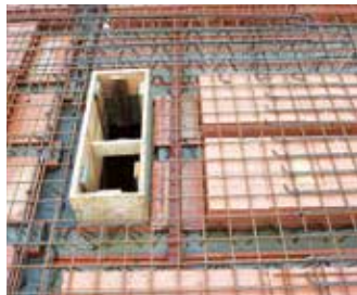
Příklady komínové výměny pomocí vložek MIAKO 8/62,5 (8/50) PTH
