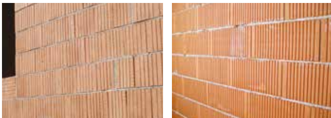
Promaltování vodorovné ložné spáry až do líce zdiva - vnější a vnitřní zdivo
