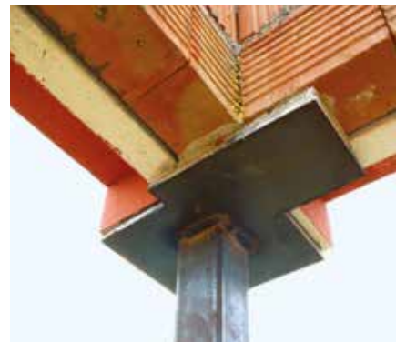
Uložení překladu KP Vario na sloupek
