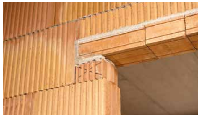
Příklad dozdívky pod a nad překladem z cihel Porotherm 11,5 Profi
