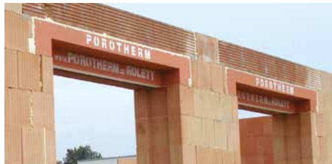
Překlady do délky 1 750 mm jsou navrženy jako plně samonosné, bez potřeby spřažení (spolupůsobení) s ostatními konstrukcemi
