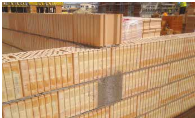
Příklad vazby zdiva a napojení akustických stěn
