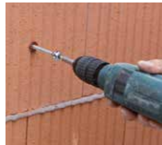
Do vnějších stěn lze kotvit pomocí běžných plastových hmoždinek
