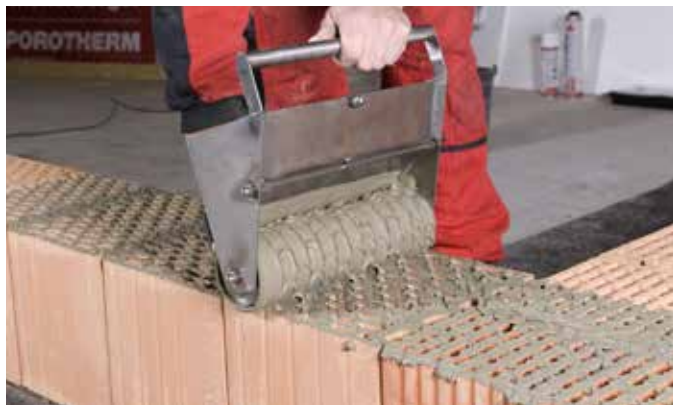
Nanášení malty pomocí nanášecího válce
