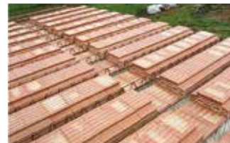
Ztužující žebro z vložek výšky 80 mm před vložením výztuže
