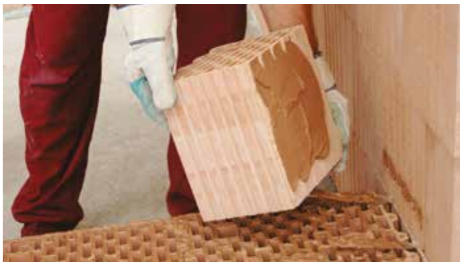
Při napojení příčky na tupo se styčná plocha namaltuje, přisadí a přimáčkne
