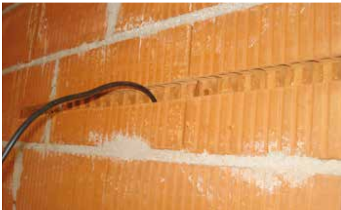
Připojení příček k nosné stěně
