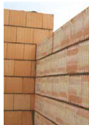
Detail napojení vnější tepelněizolační a vnitřní akustické stěny u bytových domů
