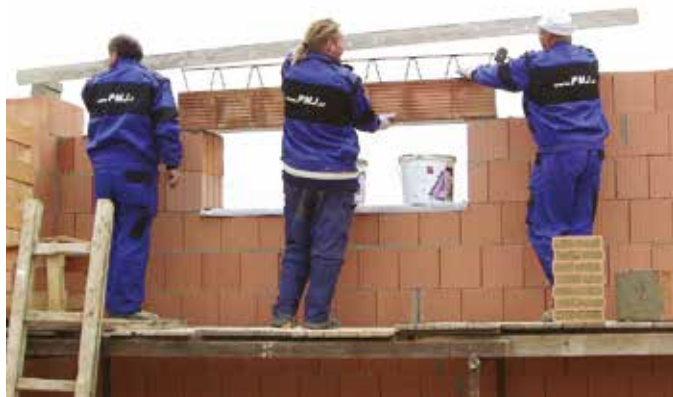
Osazování překladu KP Vario se spráhovací výtuzí do lože z cementové malty
