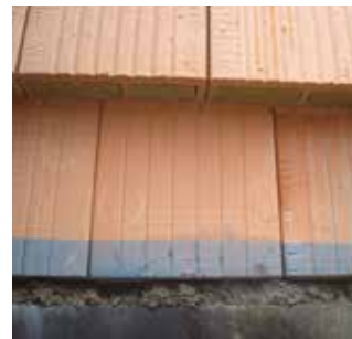
Sokl vnější stěny s použitím soklové cihly Porotherm 38 TS Profi
