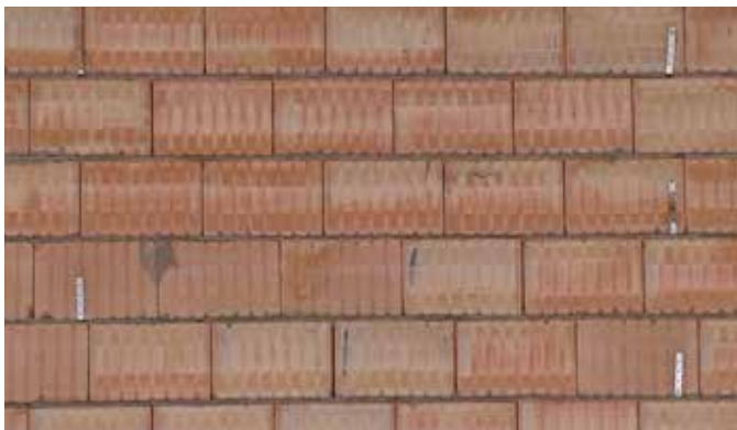
Připravené kotvy pro napojení vnitřní nosné stěny k vnější stěně
