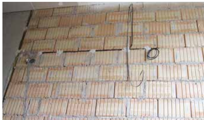
Je vhodné omezit počet elektrických zásuvek a drážek pro vedení elektrických kabelů v akusticky dělicích stěnách na minimum
