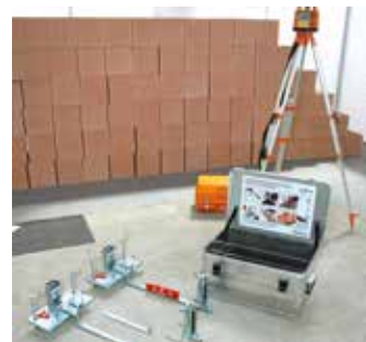
Příprava výškového zaměření základové desky
