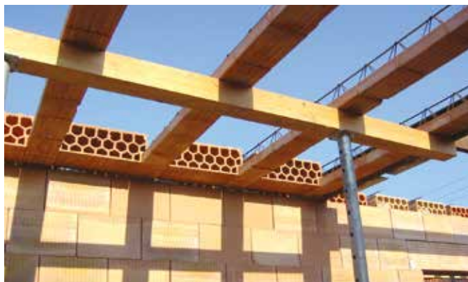
Stropní trámy se na stěny z broušených cihel mohou ukládat přímo na podložku z těžkého asfaltového pásu
