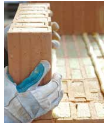
Cihly se po usazení do lepidla nesmí zvedat a ani posouvat
