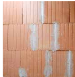
Řešením je vyplnění spáry tepelněizolační maltou nebo montážní pěnou
