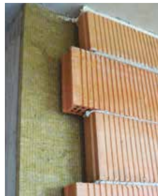
Příklady napojení přízdívky akustických stěn na svislé konstrukce
