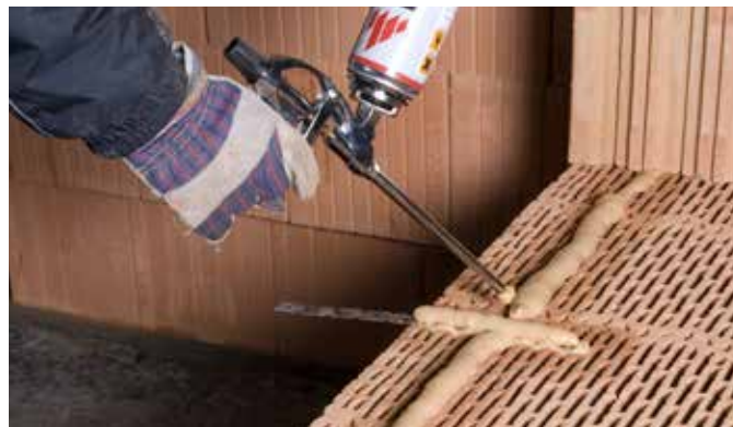
Plochou kotvu pokládáme do zdící pěny nebo tenkovrstvé malty
