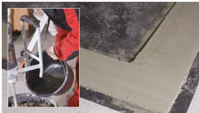
První vrstva cihel se zakládá na dokonale vodorovnou a souvislou vrstvu malty
