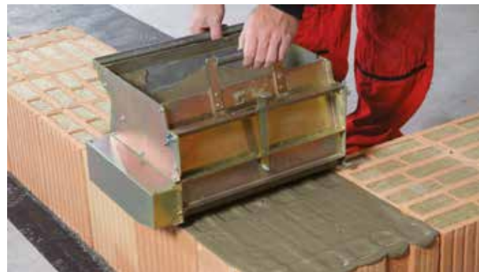
Nanášení malty pomocí maltovacího vozíku
