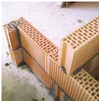
Napojení stěny z cihel Porotherm 11,5 Profi
