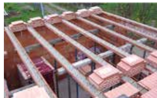
Kladení vložek na předem podepřené trámy
