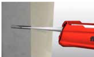
Aplikace chemické malty pomocí vytlačovací pistole se směšovacím nástavcem
