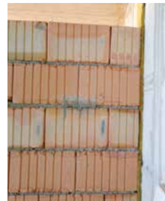
Příklady napojení přízdívky akustických stěn na svislé konstrukce
