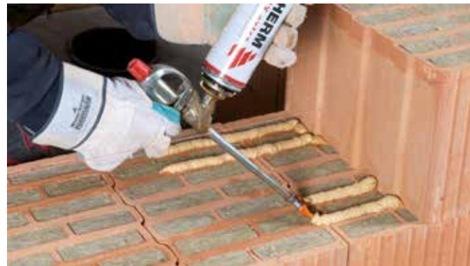
Na cihly Porotherm T Profi plněné minerální vatou se bez rozdílu tloušťky stěny vždy nanáší 4 tenké pruhy lepidla Porotherm Dryfix.extra
