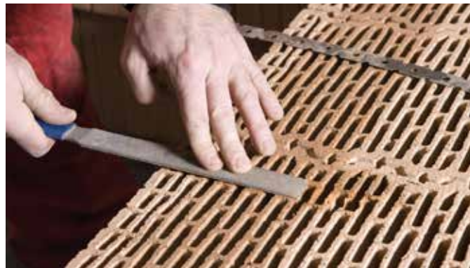
Před vložením ploché kotvy je třeba místo probrousit a poté navlhčit
