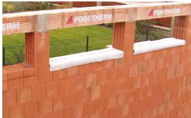
Překlady Porotherm KP 7 se vždy osazují do maltového lože tloušťky cca 10 mm z cementové malty M 10
