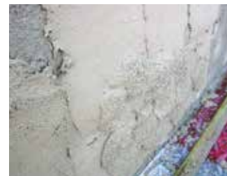
Následná aplikace tepelněizolační Baumit Termo omítky
