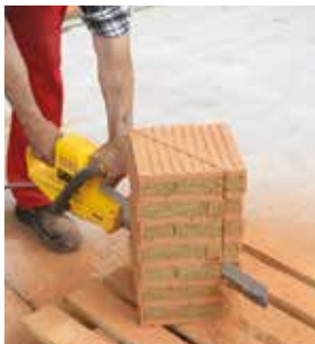
K řezání cihel doporučujeme i ruční elektrickou pilu s protiběžnými listy
