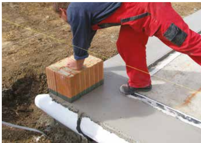
Založení cihel T Profi plněných minerální vatou
