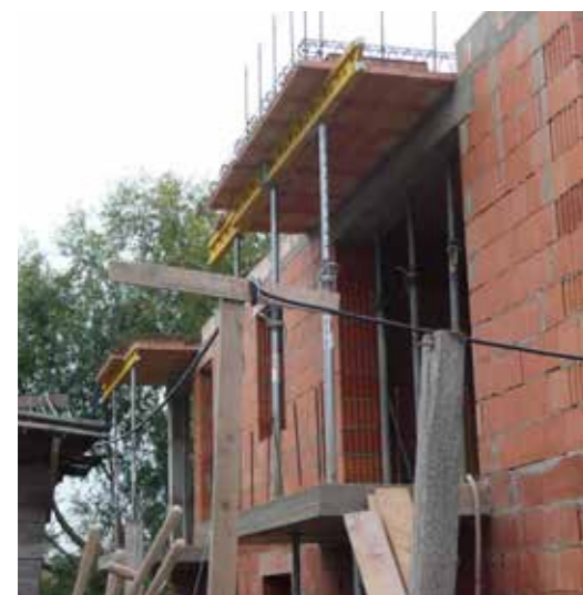
Zabetonovaná výztuž pro kotvení železobetonového zábradlí
