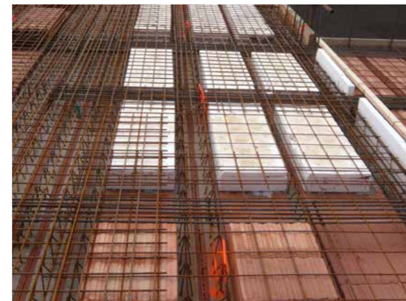
Zateplení teras u ustupujícího podlaží
