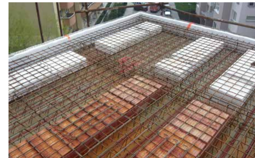
Zesílení stropu pod nosnými stěnami podél ustupující terasy
