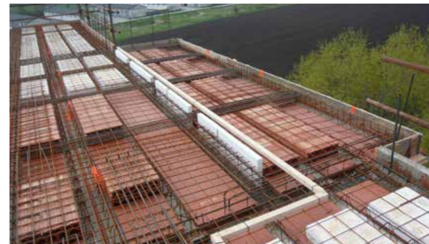
Balkón zavěšený na skrytých železobetonových žebrech
