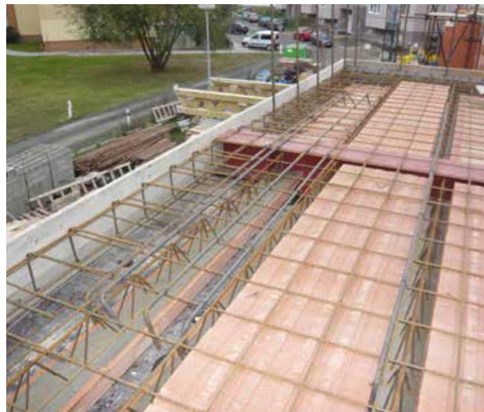
Kombinace skrytých žebrových a ocelových konzol u balkónu nad rohovým oknem bez sloupku
