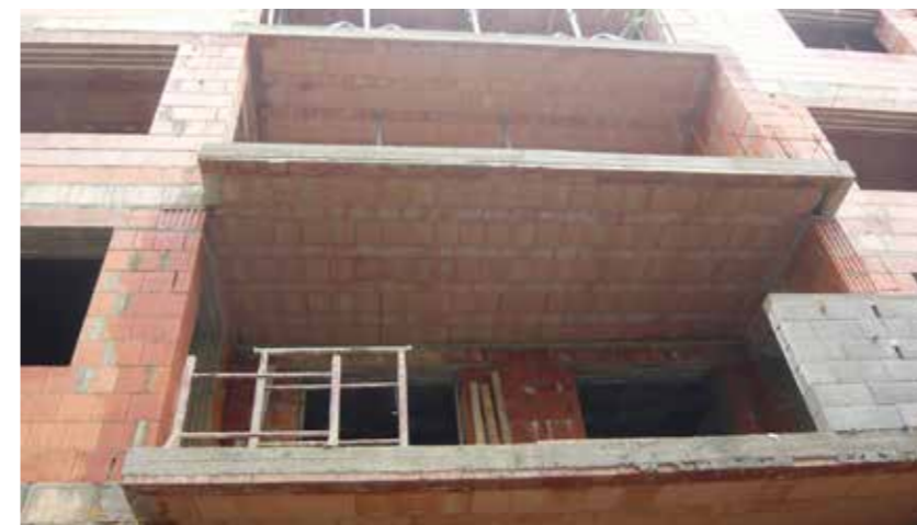
Trámy uloženy na vykonzolovaný ocelový prvek
