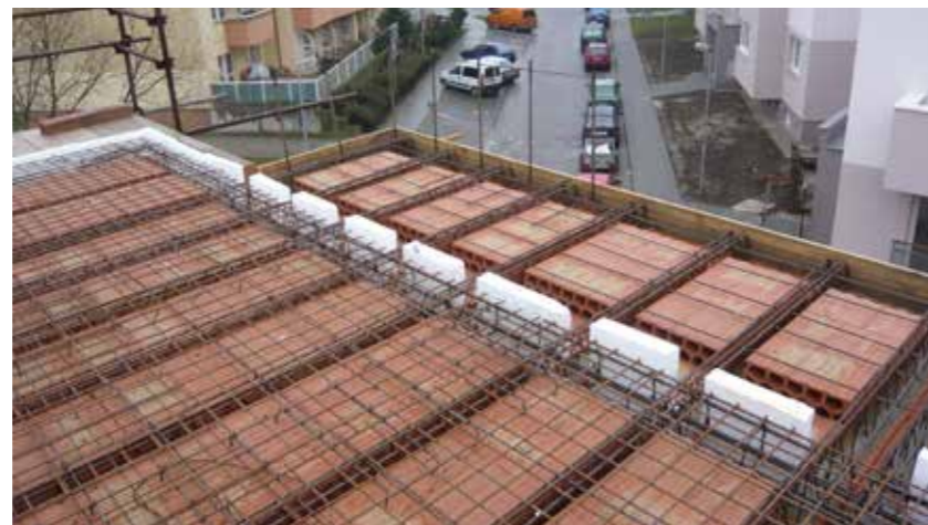
Vložení tepelné izolace na celou tloušťku stropu mezi trámy
